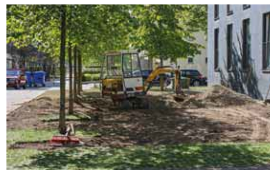
Mit dem Aushub und dem Einfüllen des Kieses wurde eine GaLaBau-Firma beauftragt
